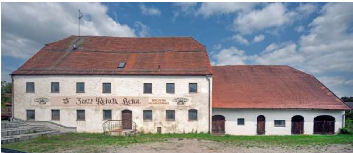
Ansicht von Süden Sept 2019
