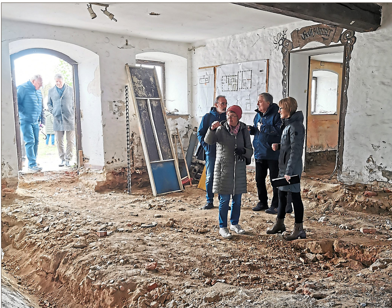
Bürger konnten das teilweise entkernte historische Gasthaus besichtigen
